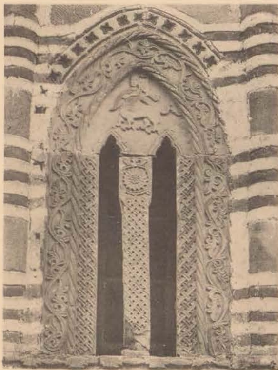
230. Kalenić. Fenêtre de l'abside latérale, au nord.
